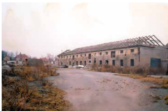
Bourání budov Dvora
